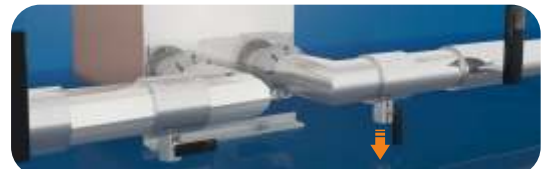
Stoppen Sie die CIP-Maschine. Lassen Sie die Reinigungsflüssigkeit aus dem Wärmetauscher und der CIP-Maschine ab.
