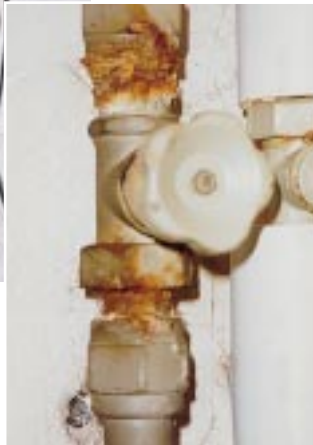
Derartig starker Rost an Heizungsleitungen ist ungewöhnlich und weckt den Verdacht auf Stromfluß als Ursache [2]
